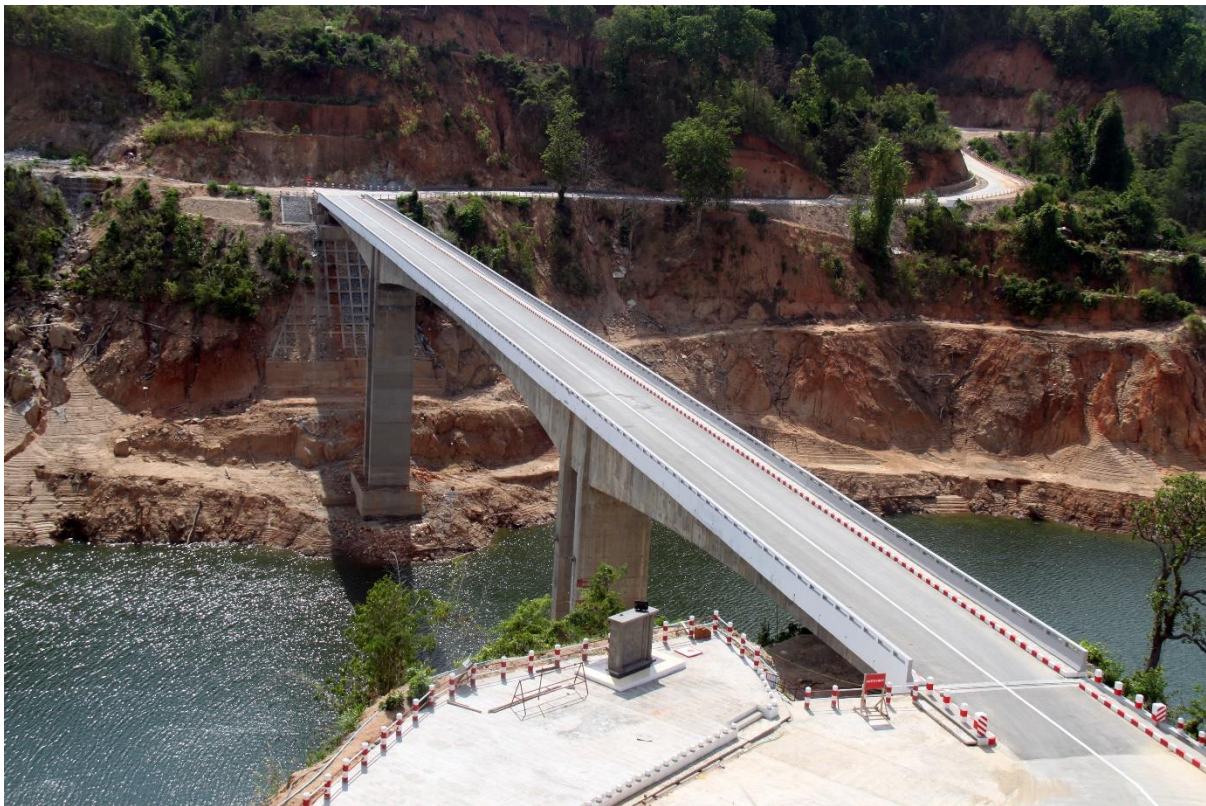
ပုံ - Prestressed Cantilever နည်းပညာဖြင့် အဆင့်မြင့်တင်တည်ဆောက်ထားသော ပလက်ဝတံတား (၁ ရည်ညွှန်း)
